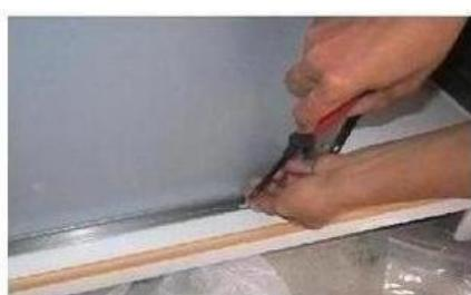
Установите собранный каркас душевой кабины на поддон /18/. Выровняйте на поддоне каркас душевой кабины по переднему бортику, просверлите отверстия на поддоне соответственно отверстиям на нижних профилях задних стенок и соедините каркас душевой кабины с поддоном саморезами 4\*15 /40/, нанесите на места соединений санитарный герметик.
