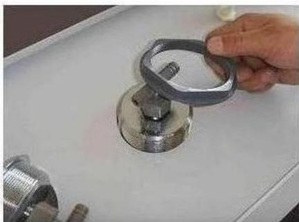
С внутренней стороны к отверстию для форсунки приложите форсунки /11/, с наружной стороны прикрепите форсунки с помощью гайки.
